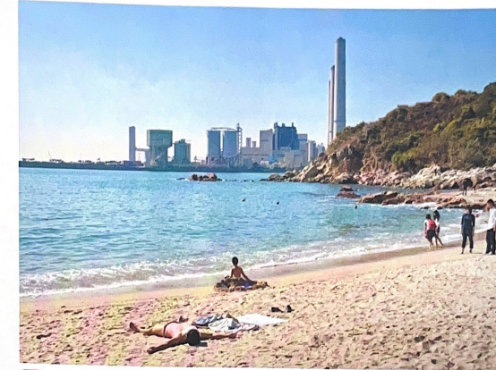
4 | Une plage devant la centrale électrique de Lamma Island
